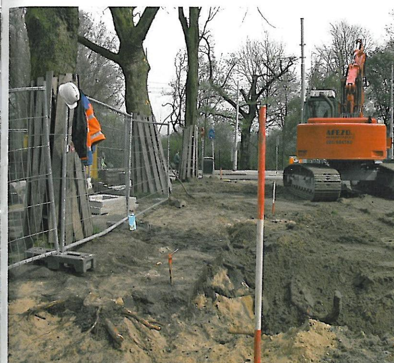
Bij graafwerk moet de toezichthouder er snel bij zijn. Wortelschade is immers gemakkelijk te vermoeden.
