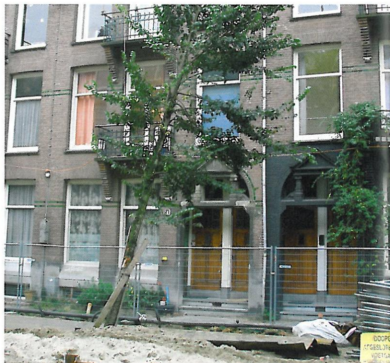
Bomen moeten het tijdens (reconstructie)werkzaamheden vaak flink ontgelden.
